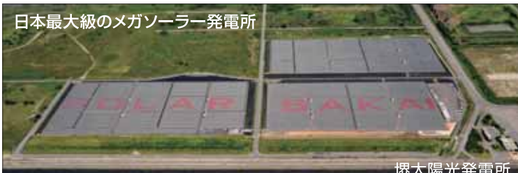
堺太陽光発電所
